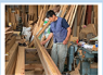
尺骨を持ってモジュールを正確に設置する中での様子各台
