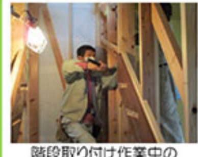
階段取り付け作業中の 勝弘君
